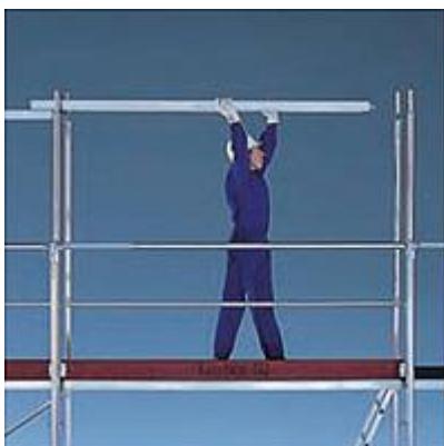
Zábradlí ztužuje lešení.
