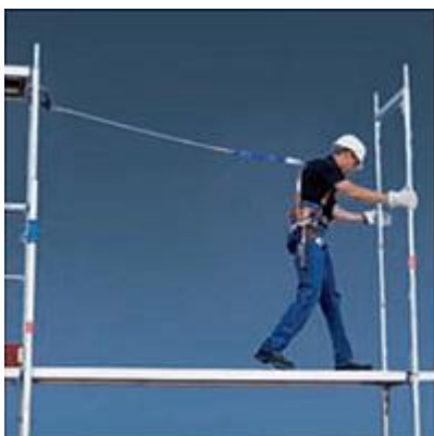
Lešeňové podlahy budou vloženy do U profilů stavěcích rámu.
