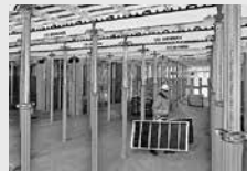
Stropní bednění
