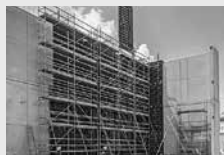
Pracovní lešení na staveništích
